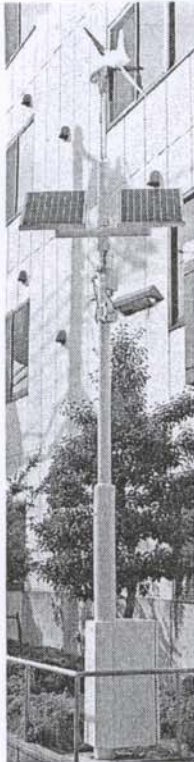
太陽光と風力発電を併用するLED街路灯―神奈川県
